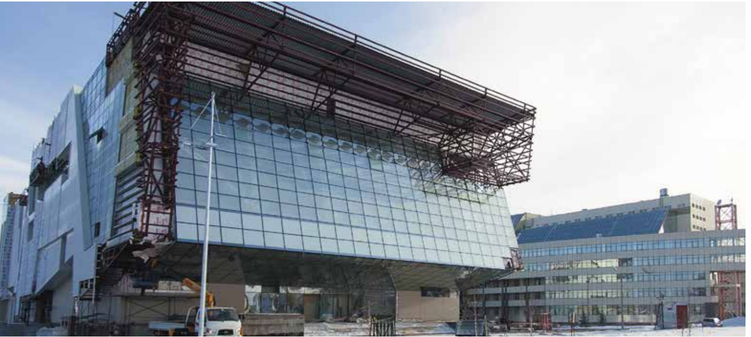
Строящийся в кампусе СФУ Общественный центр также будет активно использоваться во время Универсиады
