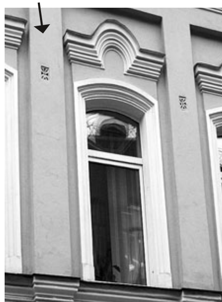
Приточные устройства в стенах старинных зданий
