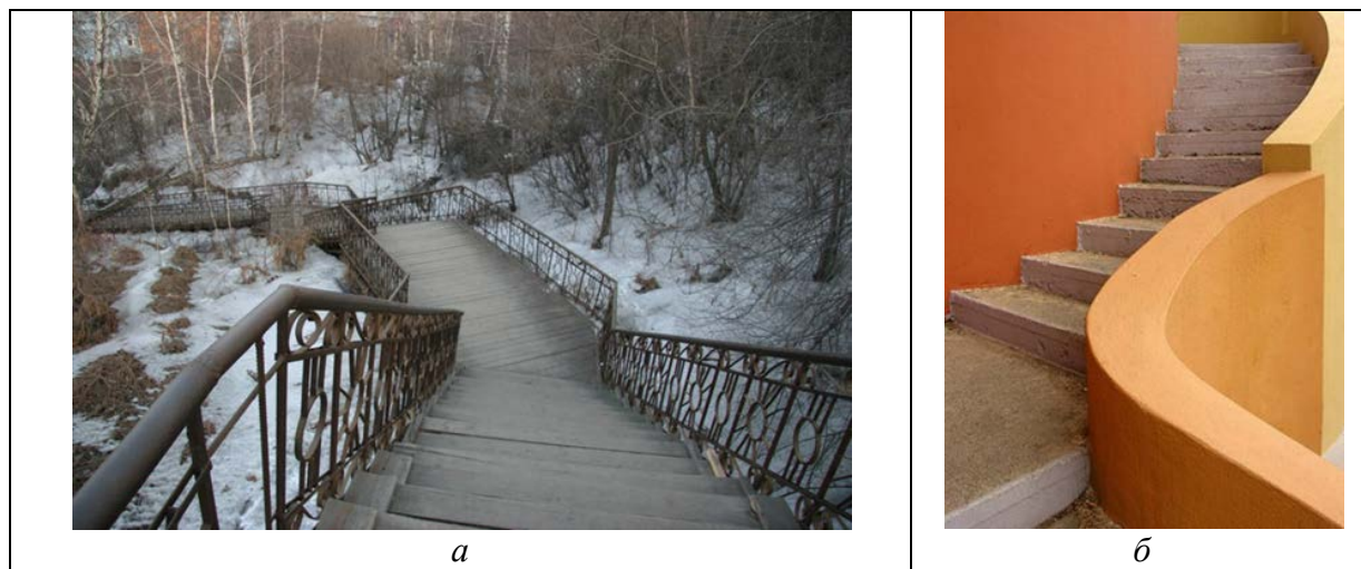
Рис.1. Ограждения лестниц: а - перила; б - подпорные стенки.
