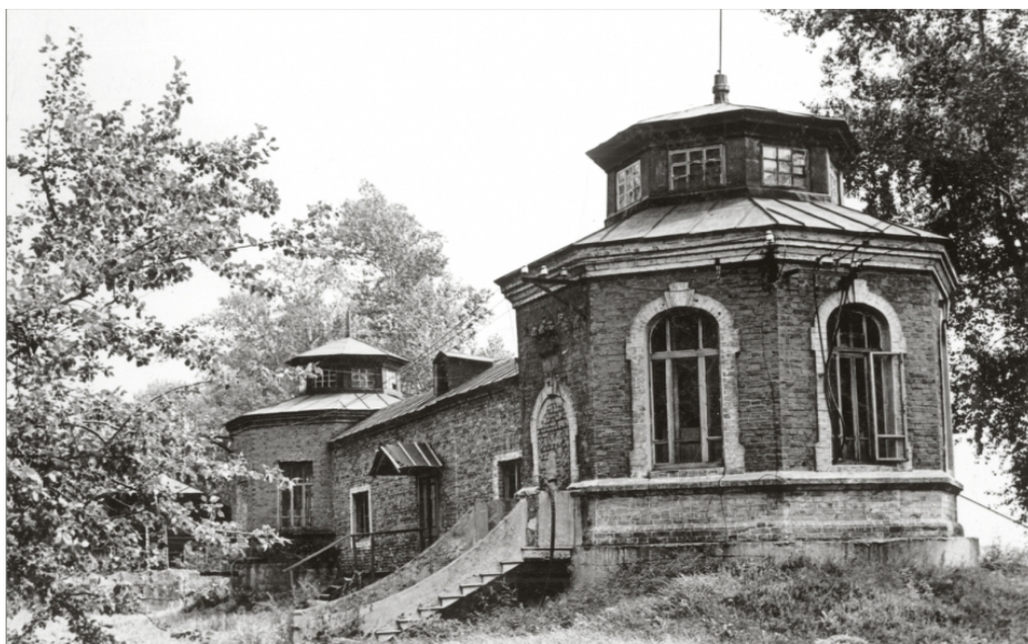
Рис. 2. Красноярск. Здание водозабора острове Посадный. (Фото с сайта http://www.kraskom.com/work/museum/ )
