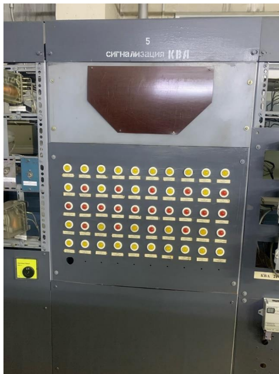
Рисунок 2.1 – Шкаф сигнализации КВА
